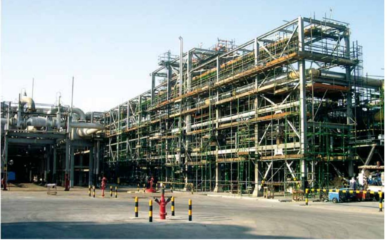
Berri Gaz Tesisi Qatif Üniteleri İnşaat ve Montaj işleri, 2002-2005, Suudi Arabistan.
