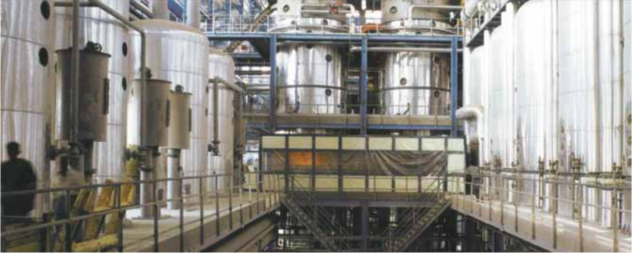
Horezm Şeker Fabrikası, 1993, Özbekistan.
