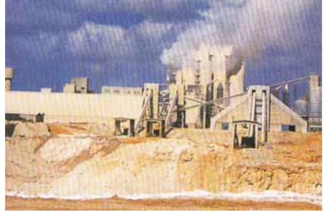
Bingazi Çimento Fabrikası, 1976, Libya.
