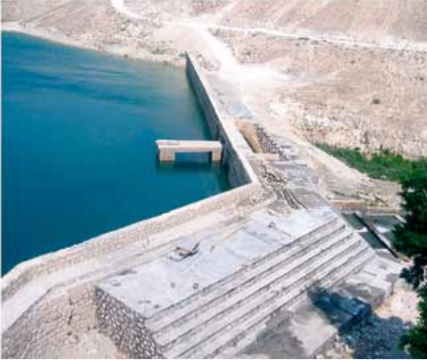
Sar-e-Haus Baraj Rehabilitasyonu, 2003, Afganistan.
