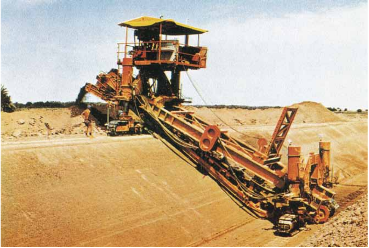
Ebu Gurayip Sulama, Drenaj ve Karayolu yapımı, 1979, Irak.
