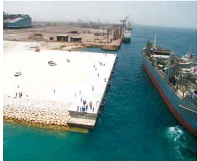
Gabbro rıhtımının genişletilmesi, 2008-2010, Doha, Katar.
