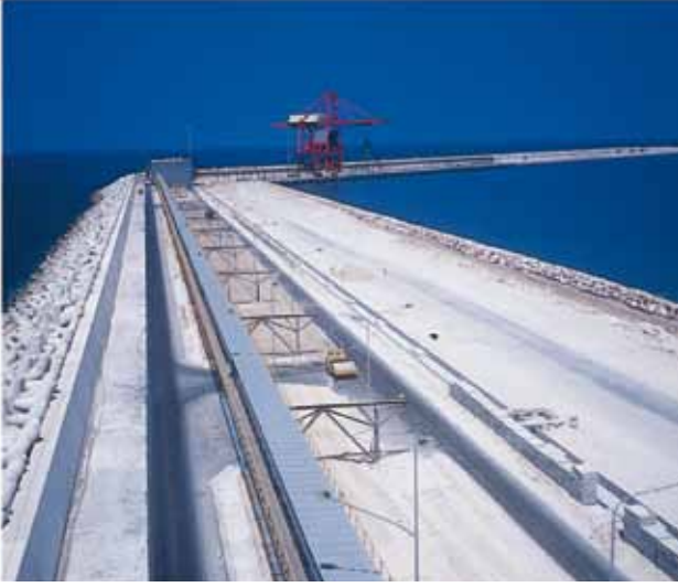
Misurata Çelik Kompleksi Limanı, 1983, Libya.
