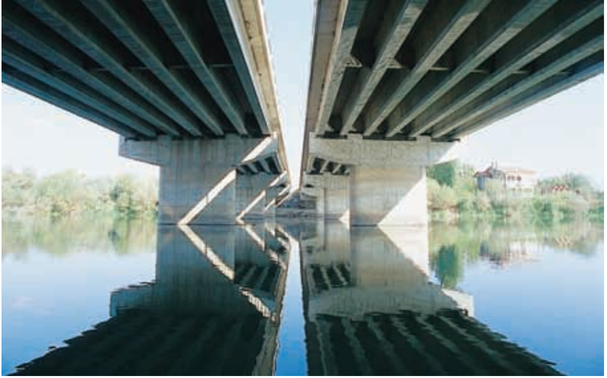
Nevşehir-Ürgüp Ayrımı Karayolu İnşaatı.
