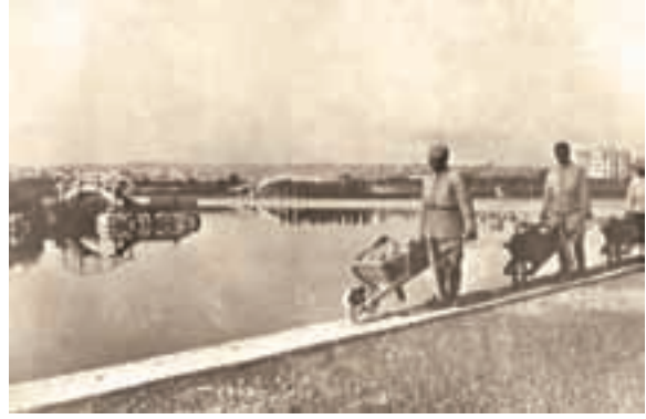
Gençlik Parkı İnşaatı. Ahmet Yüksel Arşivi.
