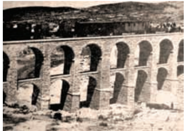
Hicaz Demiryolu Üzerinde Bir Köprü.
