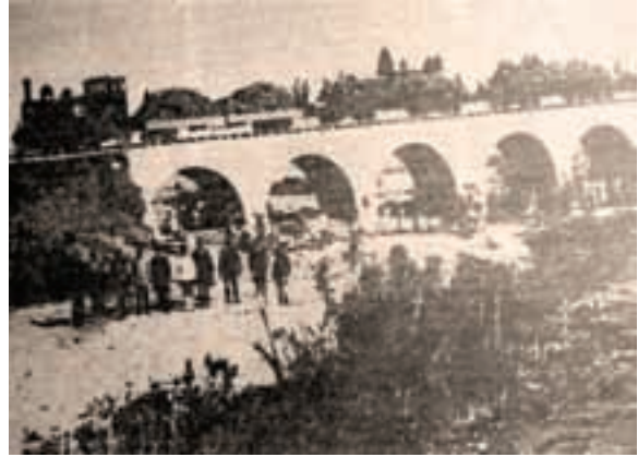
Hicaz Demiryolu İnşaatı Malzeme Treni.
