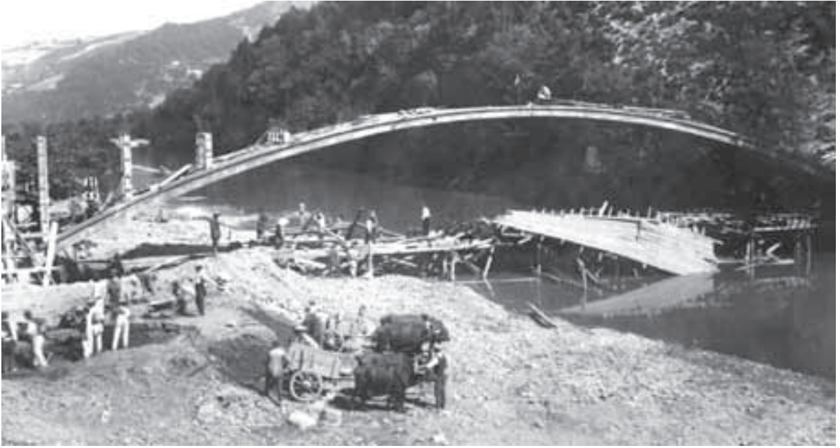
1940'larda Bir Köprü İnşaatı. Ömer Türkoğlu Arşivi.
