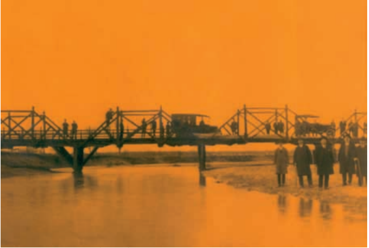
Karadeniz’de Bir Karayolu Köprüsü. Tekeli, İlhan, Selim İlkin, Cumhuriyetin Harcı: Modernitenin Altyapısı Oluşurken, İstanbul Bilgi Üniversitesi Yayınları, İstanbul, 2004.
