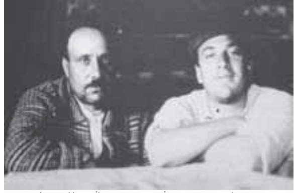
Sezai Türkes, Sadık Diri ile Poşur Köprüsü İnşaatı Şantiyesinde.
