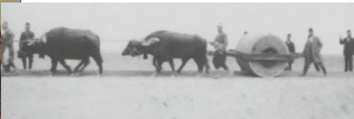
Konya Yolu Stabilizasyonu
